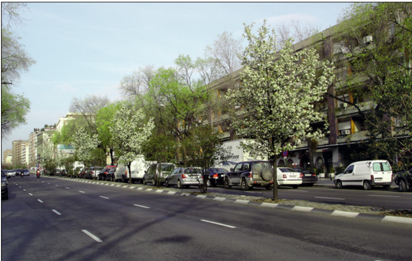
Mediana obtenida por reducción del ancho de los carriles.
