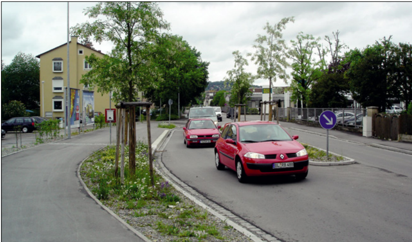
Vía con parada de bus protegida. Tübinga (Alemania).
