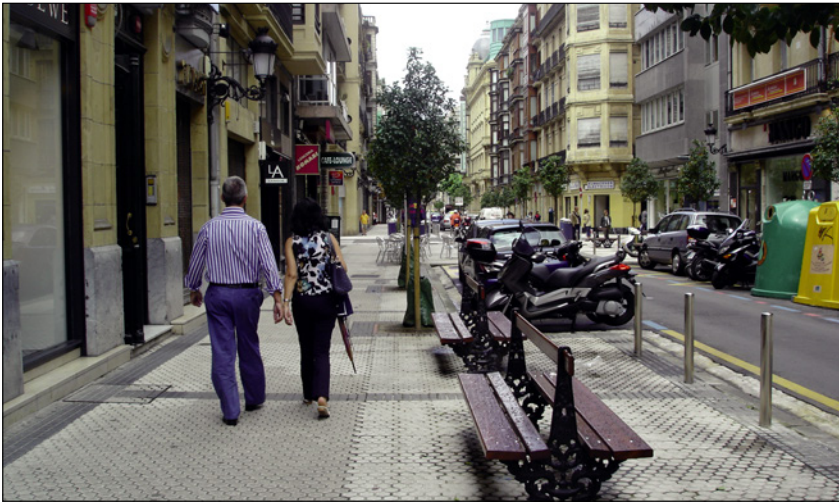
Ampliación de acera para mobiliario urbano y arbolado en una calle de Donostia-San Sebastián gracias a la reducción de la calzada y la supresión de la doble fila de aparcamiento.
