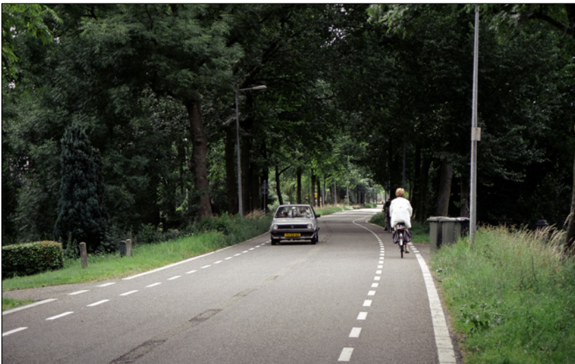
Carretera "adelgazada" por unificación de carril y creación de carriles bici laterales. Ámsterdam.
