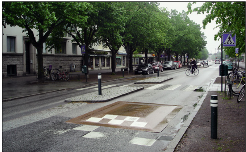
Almohada protegiendo un paso peatonal en Malmö (Suecia).
