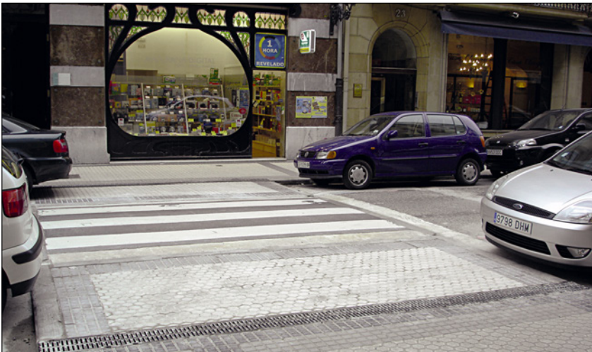
Ampliación puntual de acera en una calle de Donostia-San Sebastián.
