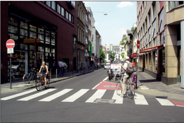
Intersección de calle con tramo de carril bici a contramano.
