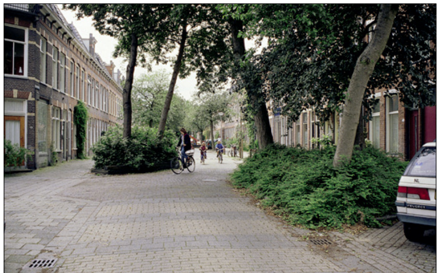
Zig-zag creado mediante disposición del arbolado.
