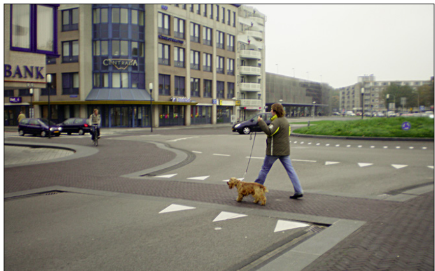
Intersección “desnuda”, en la que se han suprimido los semáforos (Drachten, Holanda).
