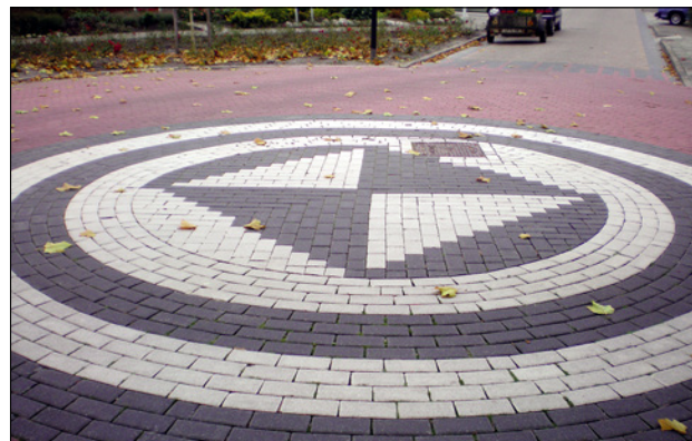
La pavimentación como elemento del control de velocidad en Ooststellingwerf (Holanda).
