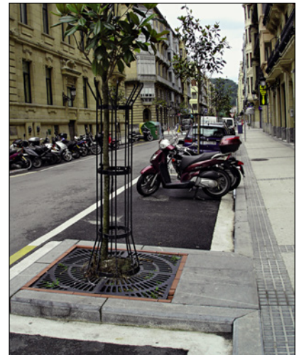
Prolongaciones de acera en banda de aparcamiento para arbolado. Donostia-San Sebastián.
