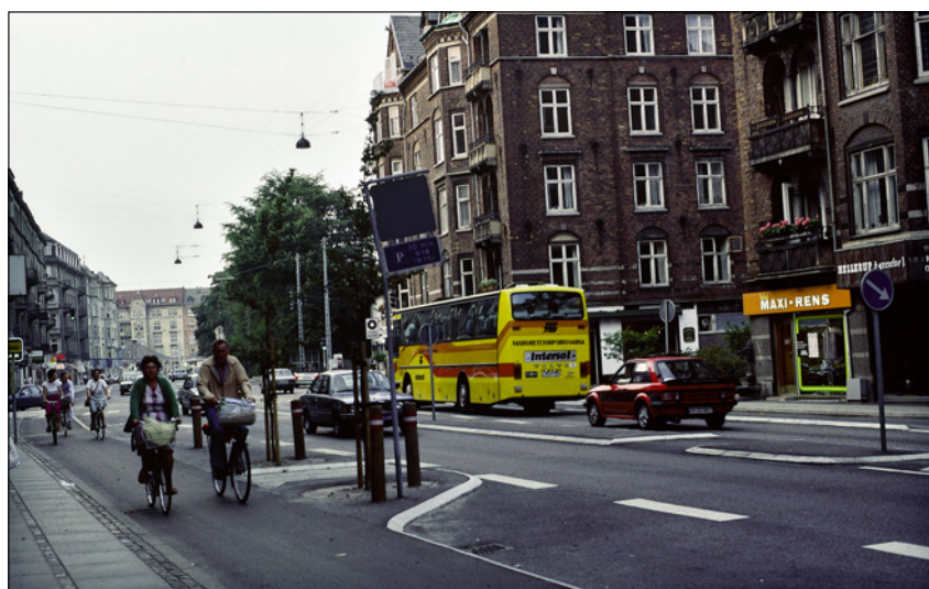
Tratamiento ambiental de una carretera en Dinamarca. Reducción de calzada por creación de pista bici y franja de aparcamiento y arbolado.
